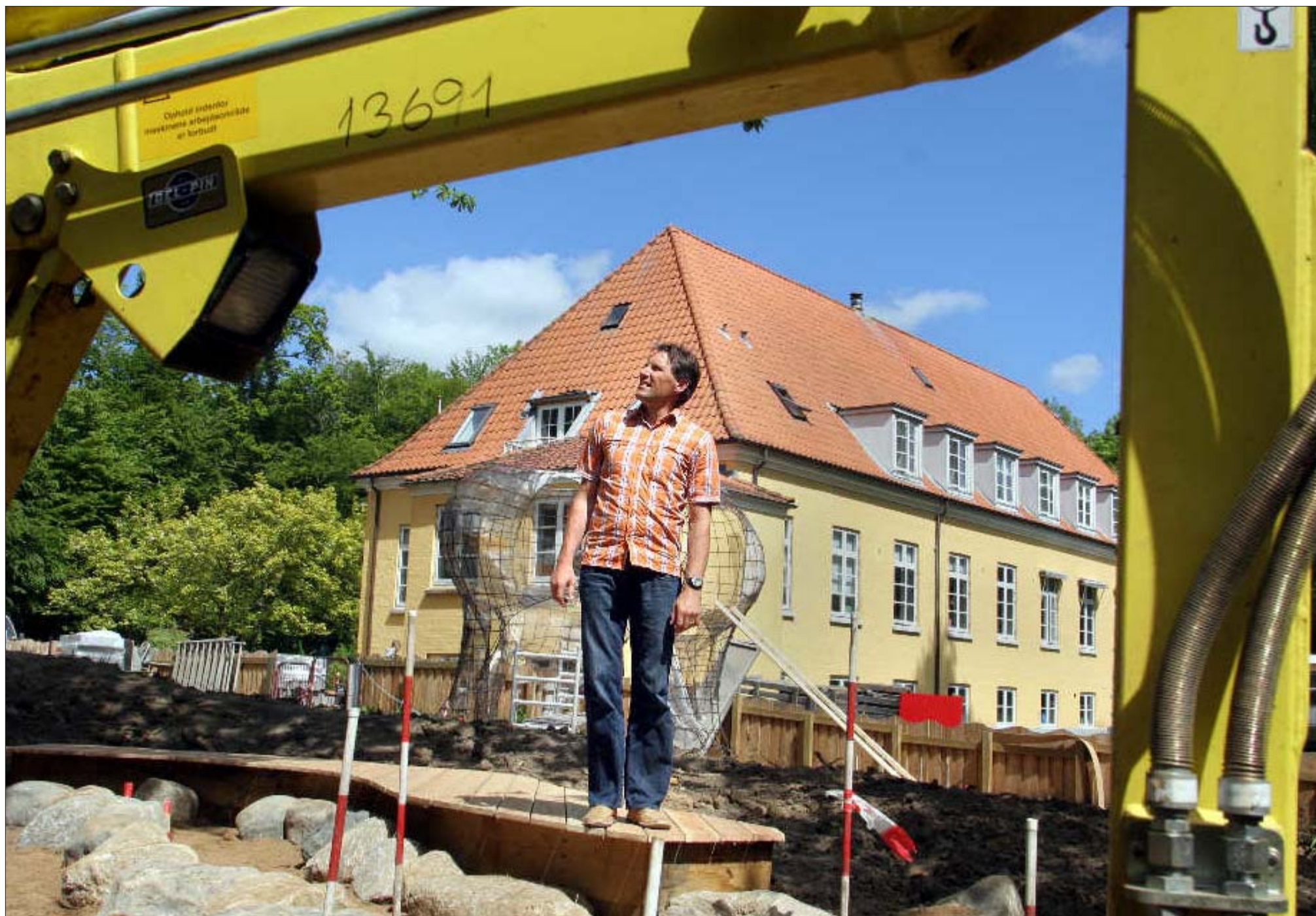
EHLERSHJEMMET. For tiden bygges ny legeplads. Efter en gennemgribende renovation af bygningen, er det nu udearealerne, der står for tur.
